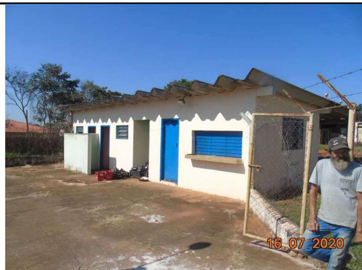
Vestiário/sanitário e bar; piso cerâmico, paredes de alvenaria, externamente revestida com reboco convencional, internamento com barrado de azulejos, forro de pvc, cobertura com telhas de cimento amianto tipo calhetão, esquadrias metálicas e madeira, pintura com tinta látex e esmalte nas esquadrias,
