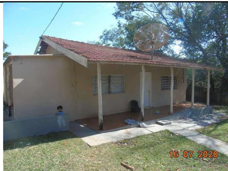
Casa, paredes de alvenaria de tijolos cerâmicos, forro de madeira, cobertura de telhas cerâmicas tipo francesa, esquadrias metálicas e/ou de madeira, pintura látex + esmalte sintético, 2 aptos. + bwc, CP = 60,00m<sup>2</sup>; 1 varanda, sem forro, prolongamento da cobertura de telhas francesas, piso de "caco" cerâmico, Área = 17,00m<sup>2</sup>; ;anexo com varanda e bwc, sem forro, cobertura de telhas onduladas de fibrocimento 6mm, piso cerâmico, Área = 23,00m<sup>2</sup>.
