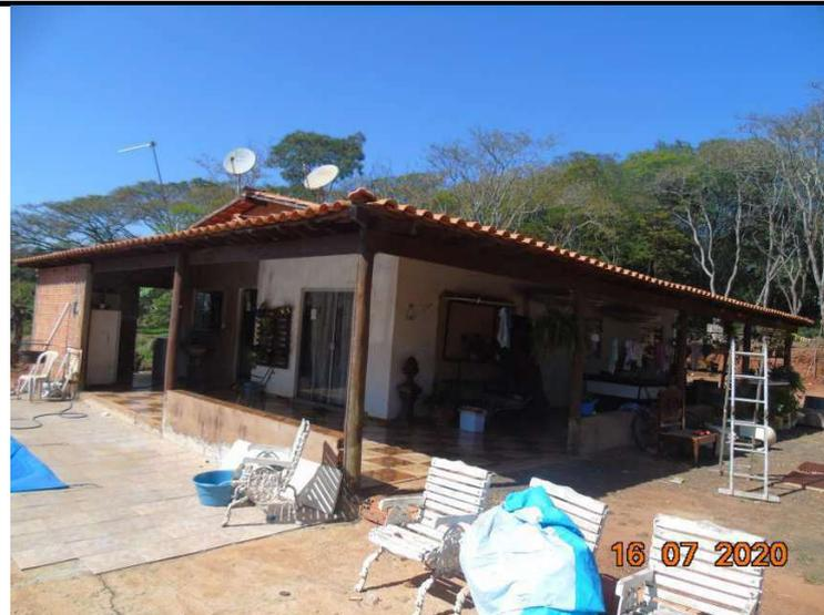
Casa, paredes de alvenaria de tijolos cerâmicos, forro de pvc, cobertura de telhas cerâmica colonial, esquadrias metálicas e/ou de madeira, pintura látex + esmalte sintético, 3 dormitórios. sala, cozinha e BWC, varanda, área de serviço piscina. áreas:
