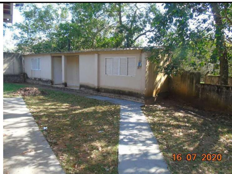
Casa, paredes de alvenaria de tijolos cerâmicos, forro de pvc, cobertura de telhas onduladas de fibrocimento de 6mm, esquadrias metálicas e/ou de madeira, pintura látex + esmalte sintético, 2 aptos. + bwc, Área = 40,00m<sup>2</sup>
