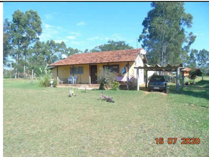
Casa com paredes de alvenaria de tijolos cerâmicos, forro de laje de concreto pré-moldada com blocos cerâmicos, piso de material cimento alisado, cobertura de telhas cerâmicas tipo francesa, esquadrias metálicas e/ou de madeira, pintura látex e/ou esmalte sintético, sendo: - Sala, cozinha, dois banheiro, dois dormitórios, cozinha, Área= 60,00m<sup>2</sup> e varanda de 20,00m<sup>2</sup>
