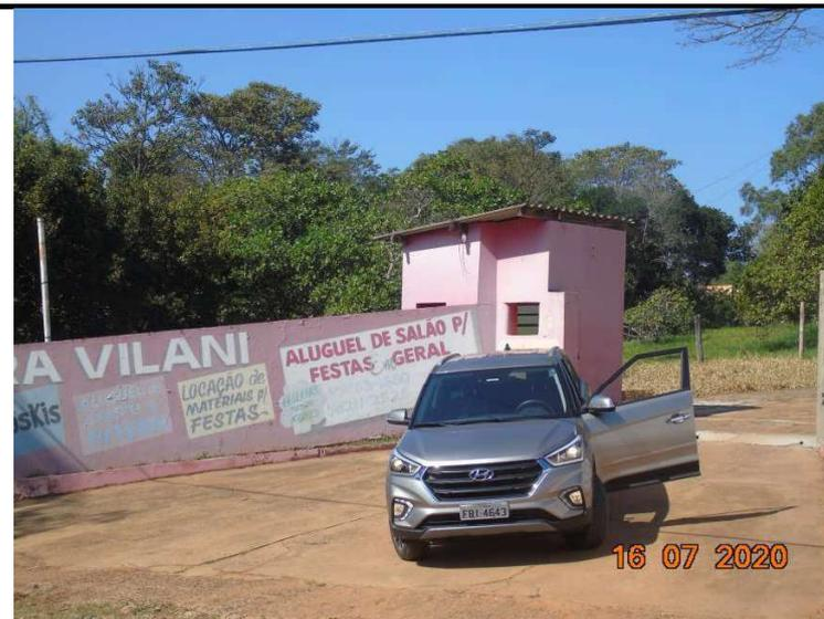
Portaria com rampa, piso em concreto polido, e portão de acesso, com paredes de alvenaria de tijolos cerâmicos, piso tipo cimentado, cobertura de telhas onduladas de fibrocimento, esquadrias metálicas, pintura à base de tinta látex, portão em chapas metálicas, pintura à base de tinta esmalte sintético;
