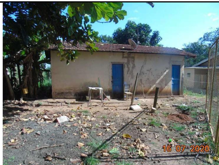
Casa, paredes de alvenaria de tijolos cerâmicos, forro de madeira, cobertura de telhas cerâmicas tipo francesas, esquadrias metálicas e/ou de madeira, pintura látex + esmalte sintético, 2 aptos. + bwc, Área = 36,00m<sup>2</sup>;
