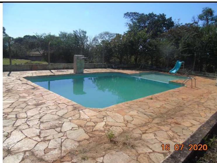
Piscinas, estrutura mista, concreto armado e alvenaria de tijolos cerâmicos comuns, revestimento de azulejos sobre paredes e pisos impermeabilizados, sendo: piscina de adultos c/ profundidade = 1,70m, prainha profundidade 0,50m ,Com equipamento de filtragem; Piso com pedra mineira no entorno
