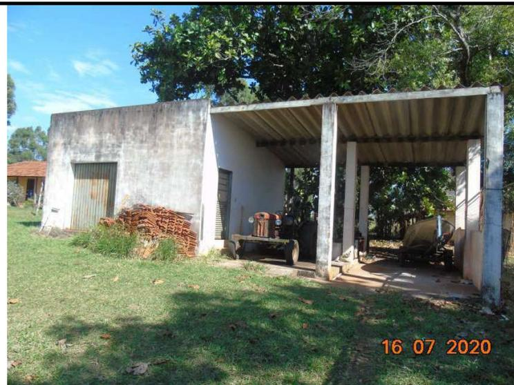
Depósito e Garagem, área aberta e/ou sem paredes, estrutura de cobertura apoiada em pilares de concreto, sem forração, cobertura de telhas onduladas de fibrocimento de 8 mm, pilares de concreto; depósito, paredes de alvenaria, sem forração, cobertura de telhas onduladas de fibrocimento de 8 mm, porta metálica, piso tipo cimentado, pintura látex + esmalte sintético,
