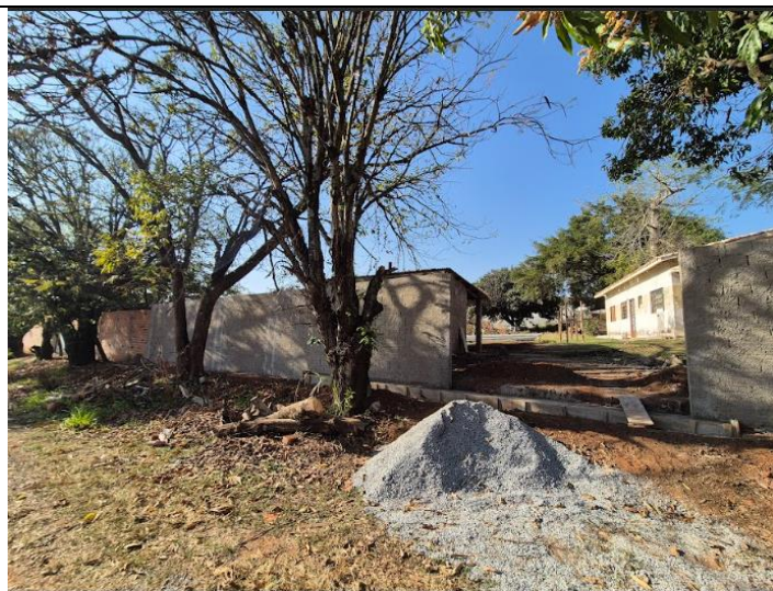
Fachada do Imóvel Lote 16 Quadra 36 MATRÍCULA 24901 Araçoiaba da Serra - SP
