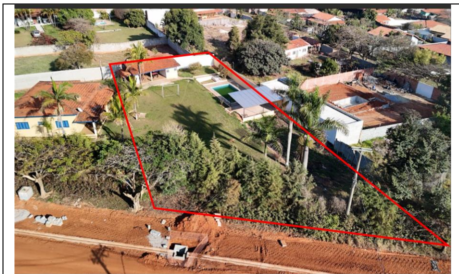
Fachada e logradouro do imóvel: MATRÍCULA 24.904
