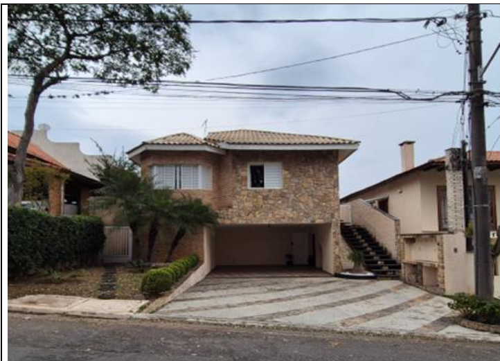
Fachada do Imóvel., Endereço: Alameda Brilhante, 529 lote 36 quadra 24 Alphaville Residencial 9. Santana de Parnaíba-SP. Matrícula 71449.
