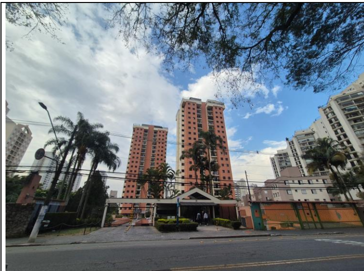
Fachada do Imóvel., Endereço: Rua Doutor Luiz Migliano nº 761, 13º Subdistrito – Butantã. São Paulo/SP. MATRÍCULA 133.876
