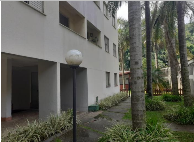
Área comum do Edifício Los Angeles - City Park III.
