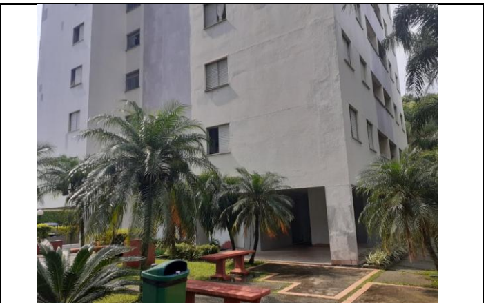
Área comum do Edifício Los Angeles - City Park III.
