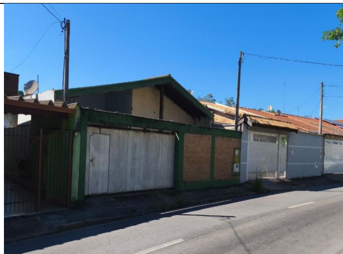
Fachada do imóvel: Endereço atual Avenida Eduardo de Castro, nº 339 - Várzea Paulista – SP.
