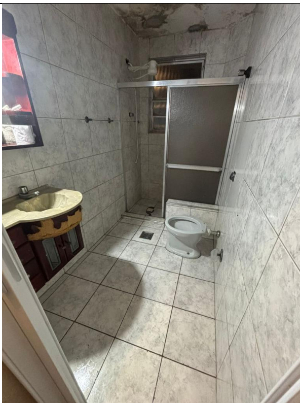
Banheiro - Apartamento 07, localizado no andar térreo, Bloco B do Conjunto Residencial Tavares.
