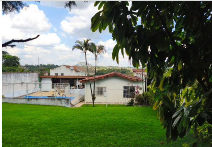
Imagens da área interna do imóvel situado na Rua João Adelino Pinto, 600.
